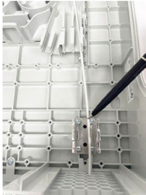
6.32 Kabel in entsprechenden Port einführen und Absetzpunkt des Kabelmantels markieren.
