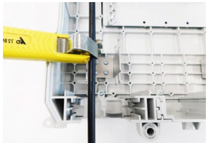
6.14 Kabelmantel ab der Markierung entfernen. Wichtig: Es werden ca. 1,8m Bündelader/Faser benötigt um 1,5m Faservorrat in die Spleißkassette abzulegen.
