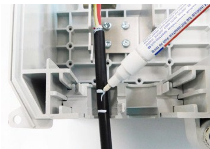
6.15 Kabel in die Kabeleinführung einlegen und Abdichtbereich markieren. Anschließend ist der Kabelmantel in diesem Bereich entsprechend des Außendurchmessers mit Schaumband aufzudicken. Die benötigte Länge des Schaumbandes ist der Tabelle zu entnehmen.
