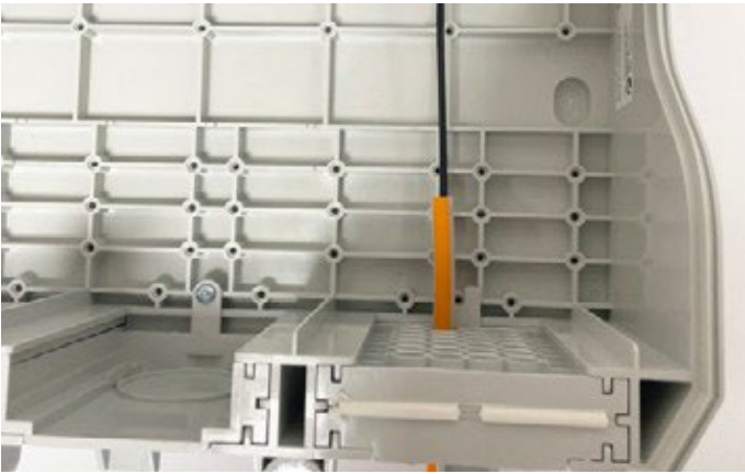
6.4.3 Mikrokabel einblasen. Wichtig: Es werden ca. 1,8m Kabel benötigt um 1,5m Faservorrat in die Spleißkassette abzulegen.
