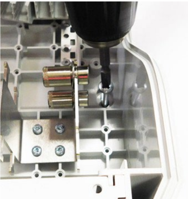
5.1.3.3. Gehäuse mit den Schrauben an der Wand montieren.
