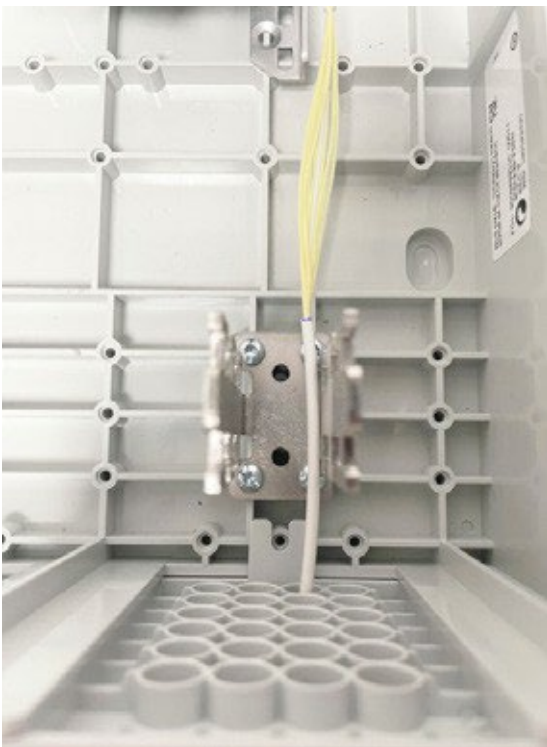
6.33 Kabelmantel ab der Markierung entfernen. Wichtig: Es werden ca. 1,8m Bündelader/ Faser benötigt um 1,5m Faservorrat in die Spleißkassette abzulegen.
